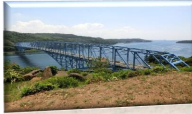
九州本島と長島をつなぐ黒之瀬戸大橋 (手前が長島)
